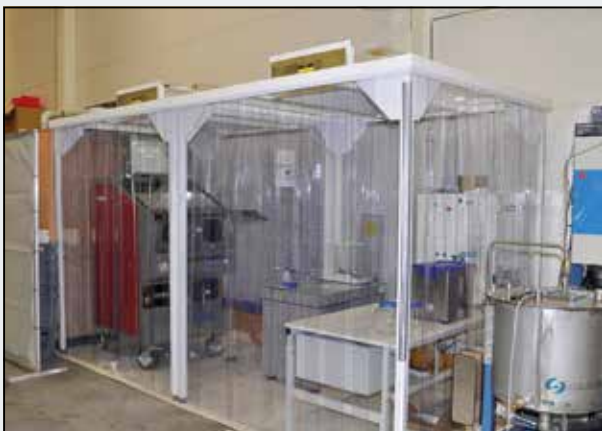
Uusi kevytrakenteinen ylipaineistettu tuotannon puhtauden tutkimuslaboratorio.
