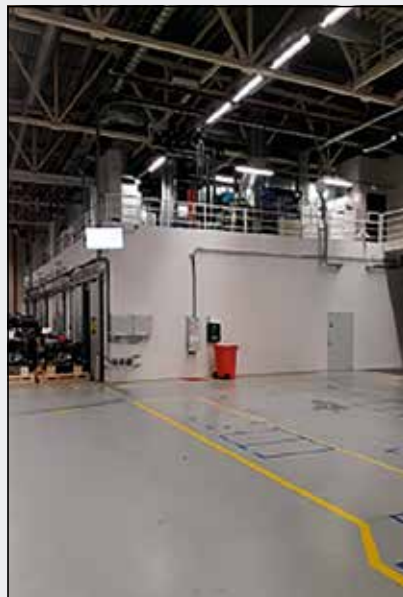
V12-linja on purettu. Tilalle rakennetaan kaksi uutta koekäyttökoppia sekä valvomotilaa.
